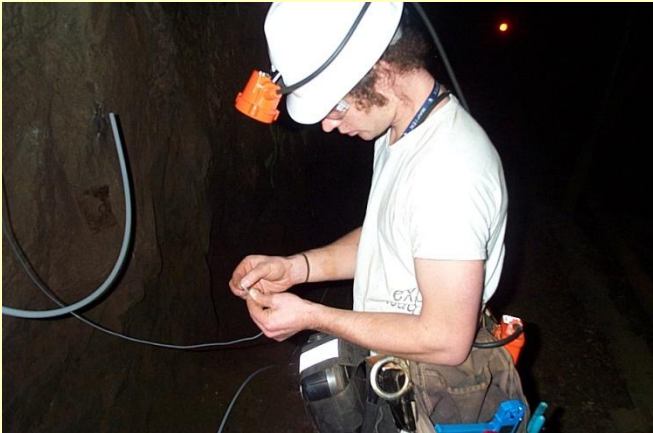
Jason Van Beek terminating data cable
